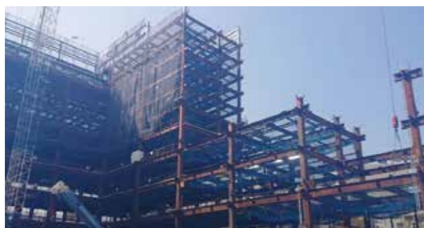
那覇市壺川3丁目プロジェクト新築工事（鉄骨工事）2019年
