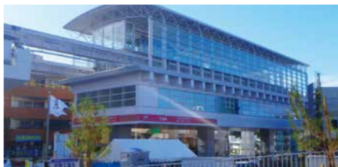
市道石嶺線 都市モノレール石嶺駅建設工事（建築）（鉄骨工事）2018年
